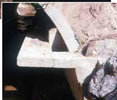
On peut cependant s'interroger sur l'efficacité de ces encorbellements car il s'agit d'équipements très artificiels. Le Vison d'Europe vit en effet au niveau du sol et il risque d'être rebuté par l'ascension d'une dalle de béton accrochée en hauteur. La dalle de béton doit être raccordée avec soin à la berge naturelle en créant une rampe en pente douce remontant du niveau d'étiage jusqu'à l'encorbellement.
