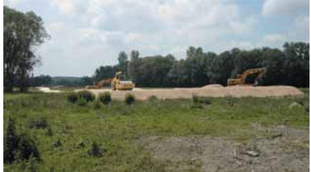
On réalisera plutôt un abattage des arbres à la tronçonneuse et ce n'est qu'après leur enlèvement que les travaux de terrassement pourront commencer.
