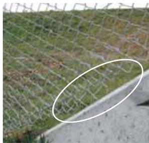
Défaut de raccordement à l'ouvrage hydraulique
