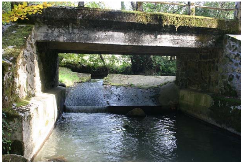
Photographie 17 : digue du Pont du chemin d'accès au Moulin de Tribier
