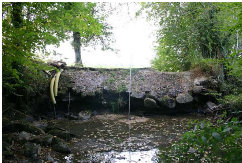
Photographie 19 : digue du Moulin de Tribier, non équipée et sans débit réservé, septembre 2005
