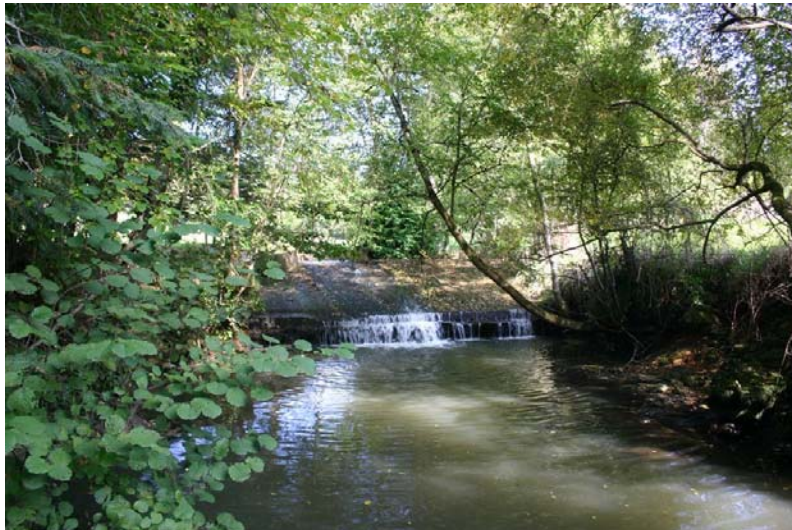
Photographie 15 : digue infranchissable de l'ancienne usine de La Grafouillère, septembre 2005
