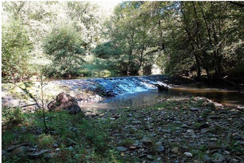
Photographie 10 : Digue infranchissable du moulin du Bouyre, septembre 2005.
