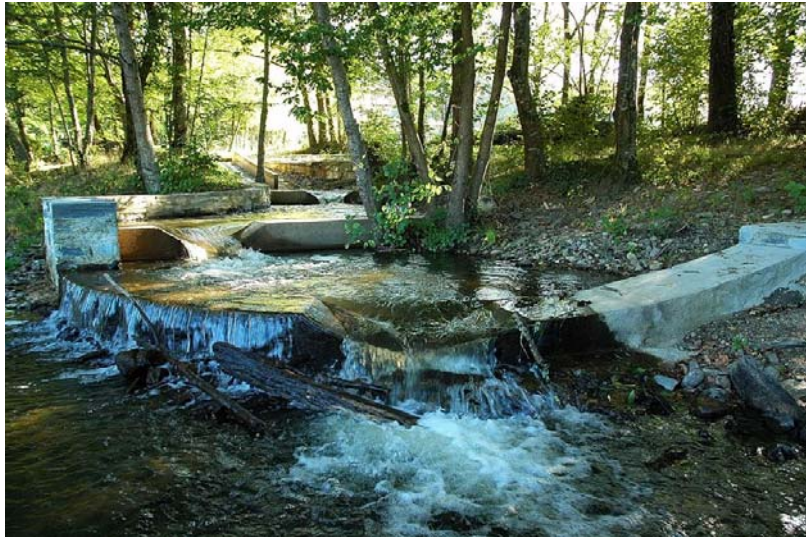
Photographie 8 : Passe à poissons de la digue du Moulin Neuf, septembre 2005.
