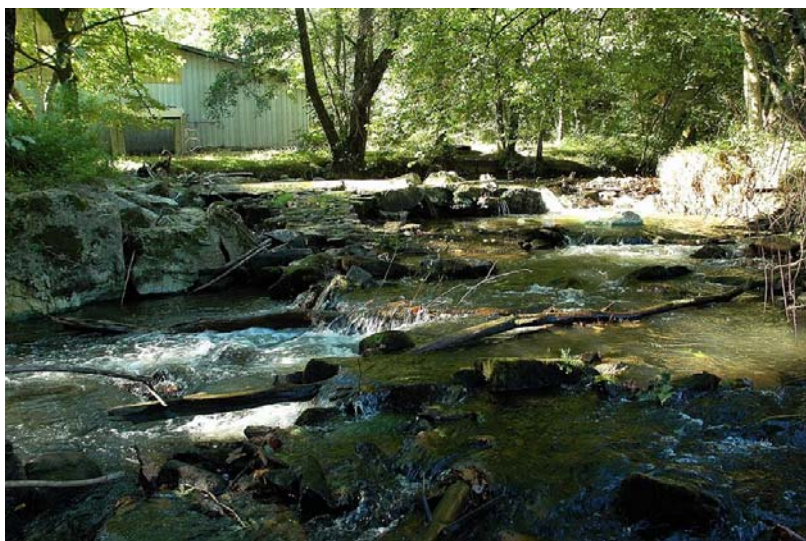
Photographie 9 : Digue éventrée de l'ancienne usine, septembre 2005.
