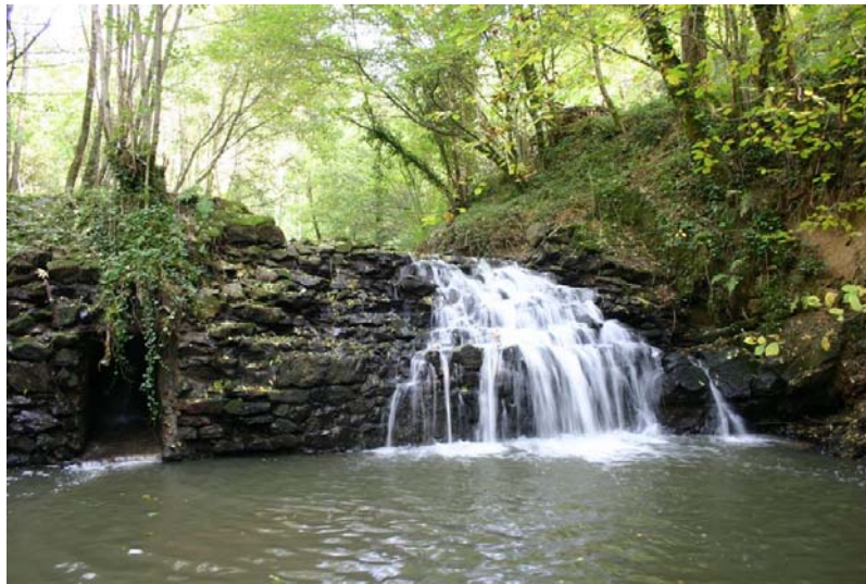
Photographie 16 : ancienne digue en pierre maçonnée en aval du Pont du Noir
