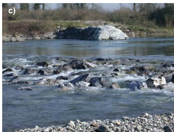
Figure 12 : Seuil en enrochements jointifs de Lescar, a) vue générale, b) vue de la partie basse, c) vue de la partie haute.
