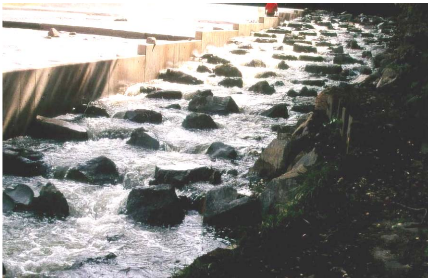
Figure 7 : Ecoulement au travers d'enrochements en rangées périodiques
