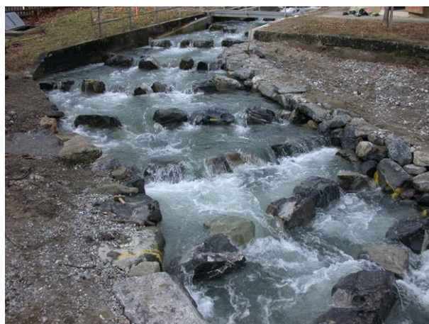
Figure 27 : Rivière de contournement sur l'Aare (Suisse)
