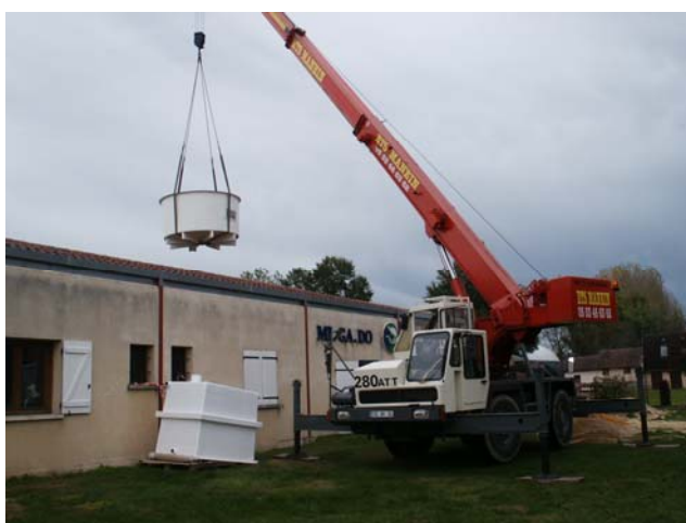
Agrandissement des installations (tranche Garonne 2005)
