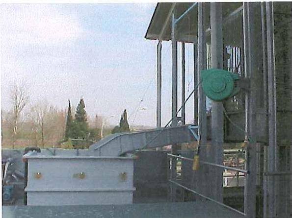
Grâce au système de poulies et treuils, la goulotte est reliée à la nasse. Lorsque cette dernière est en position de vidange, la goulotte se positionne alors horizontalement permettant un déversement optimal dans le bassin de réception
