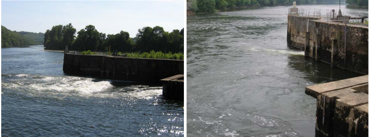
Photos 3 et 4 : Entrée aval du dispositif de franchissement avec fonctionnement maximal (à gauche) et fonctionnement réduit (à droite) du groupe 6
