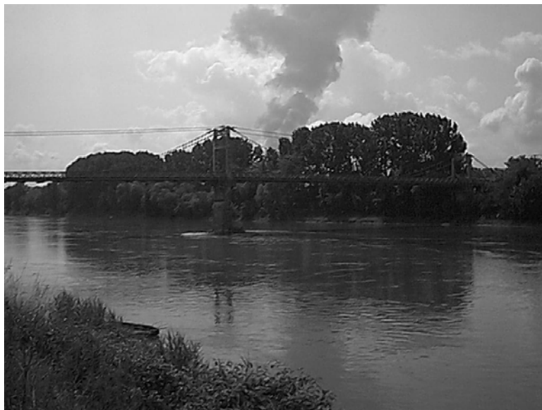
Figure 8 : Vue de la frayère de Lamagistère
