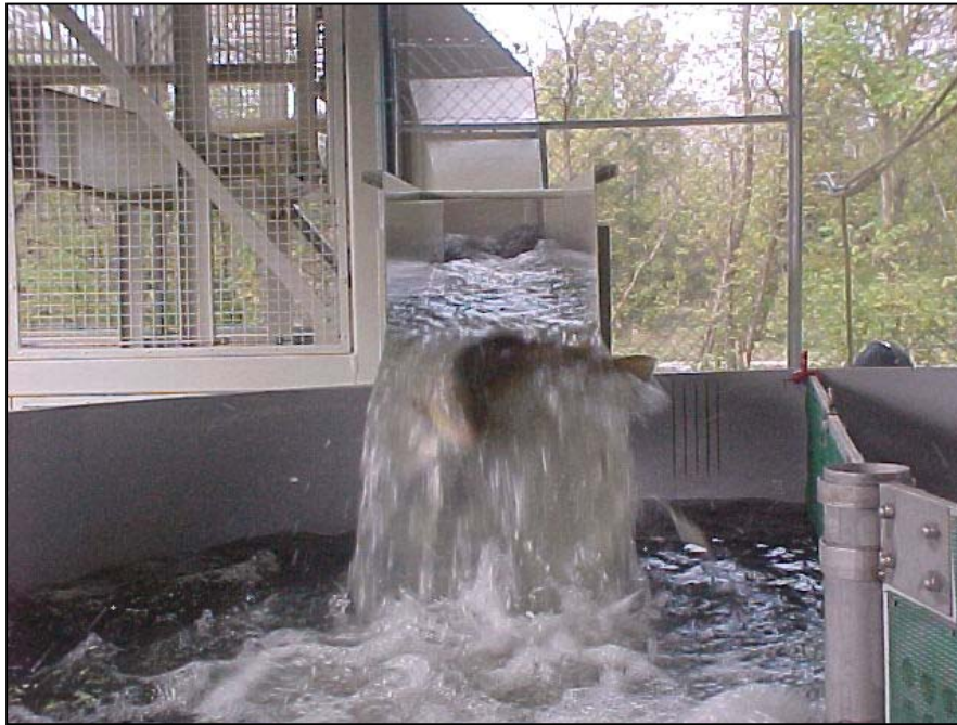
Photo 1 : Déversement d'un salmonidé dans la goulotte de l'ascenseur
