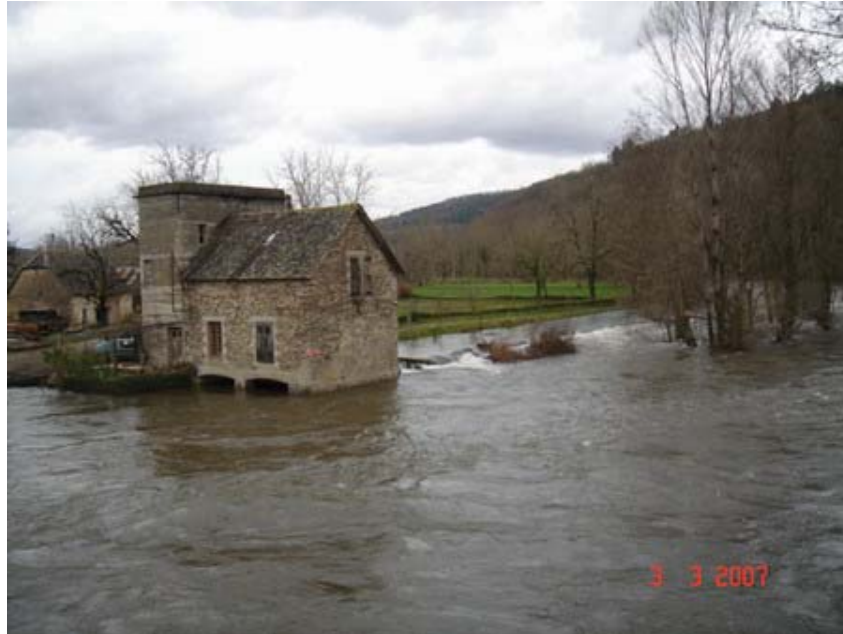
Photo 1 : La Maronne au moulin de l'Hospital lors de la crue de mars 2007
