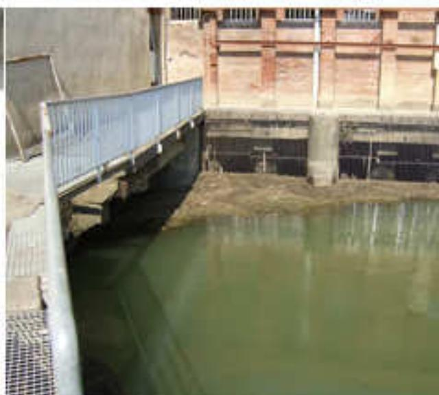
Vue des grilles amont de l'usine colmatées situées en vis à vis de la passe (01/07/2007)
