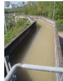
**Figure 27 : Canal de transfert (passe à poissons)**
