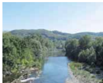
Du Pont de Mauran
