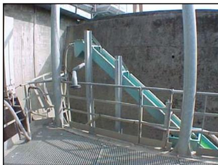
**Figure 13 : Vue de la passe expérimentale à anguilles installée à Golfech en 2002**
