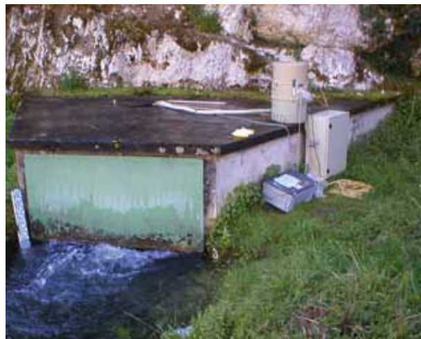
Captage de la source du Bournac (Lot) Captage de type A - Photo GINGER
