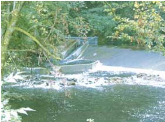
Au Moulin du Sapinier, le projet initial était "trop exigeant en entretien", avec une vanne asservie au niveau amont par flotteurs mobiles. Le principe de 5 bassins successifs à orifices noyés a été préféré pour sa rusticité. Coût total de l'opération : 56 000 €.
