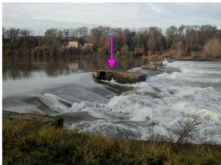
Figure 17 : Pile principale fendue et s'inclinant vers l'aval [4]
