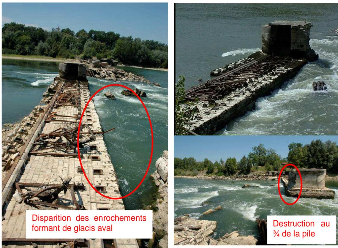
Figure 75 : Passe profonde et destruction au trois quart de la pile principale Sources : Photographies réalisées par le SMEAG le 17/08/2006
