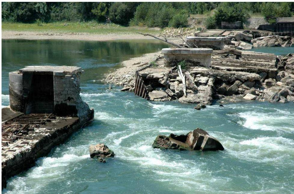
*Figure 18 : Brèche au niveau de la passe supérieure n°5. Noter le niveau d'étiage en juillet 2006 plus bas que la passe profonde. Photographie : SMEAG.*
