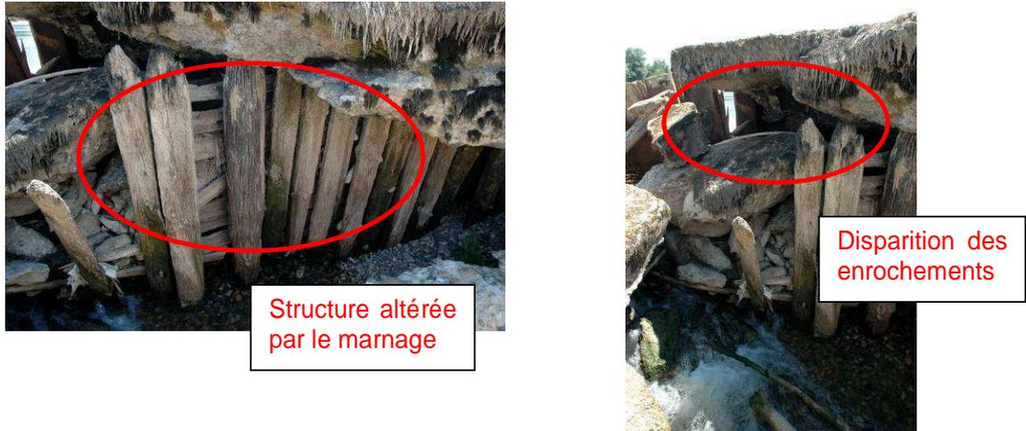
Figure 78 : Rideau de pieux en bois sous le parement aval du seuil. Source : photographies réalisées par le SMEAG le 18 juillet 2006
