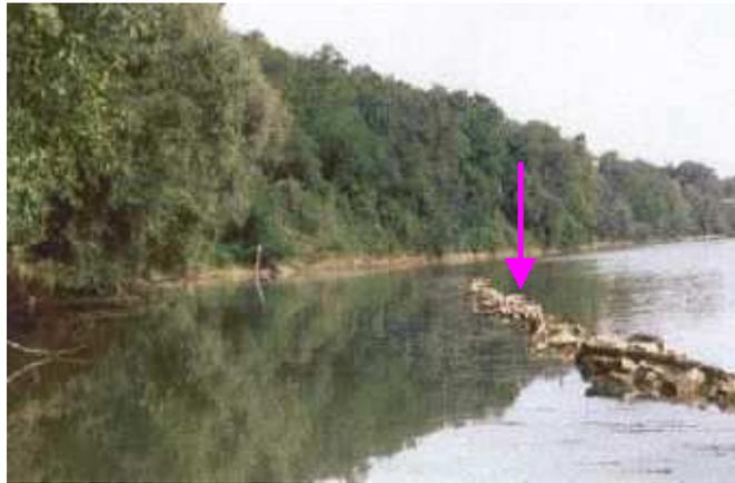
*Figure 27 : Erosion de berge au niveau du lotissement de Bellevue derrière d'anciens enrochements de navigation fluviale [6].*
