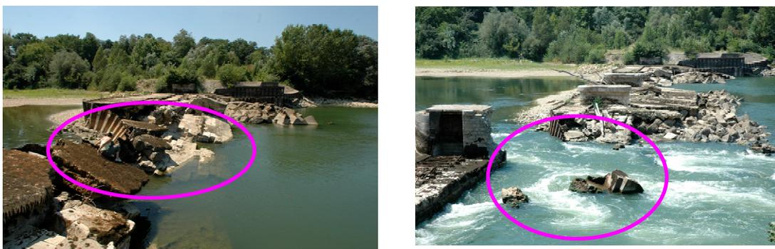
Figure 10 : Vues du seuil de Beaugard en situation actuelle (photos du SMEAG, juillet 2006 du SMEAG) et éléments de maçonneries et de palplanches à évacuer
