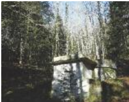
Captage de source
