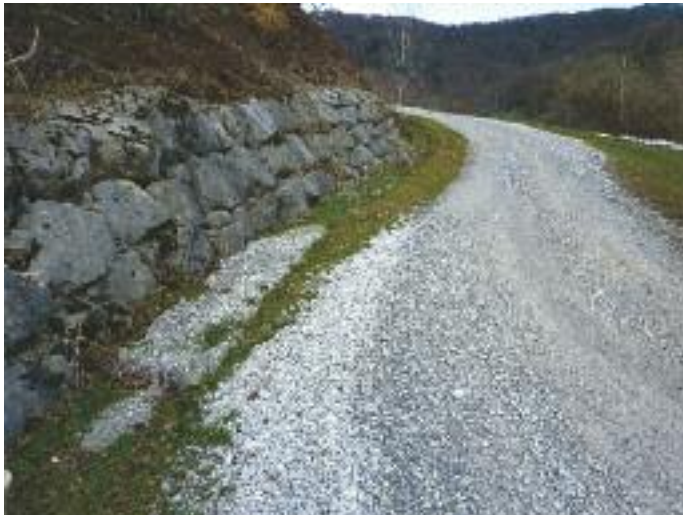
Enrochement de talus
