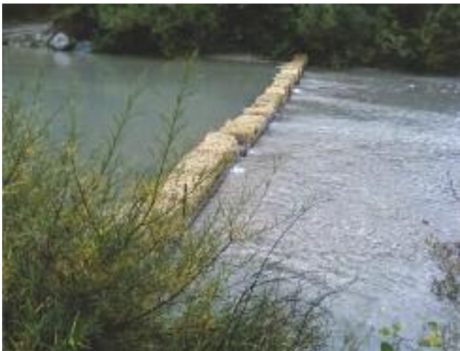
Balles de paille en travers d'un cours d'eau
