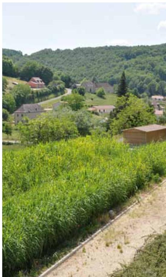
Marc Boucher souligne l'importance des phases de repos assurées par une alternance hebdomadaire des filtres: cela permet régulation de la biomasse, minéralisation du carbone et oxydation de l'azote. Les services techniques doivent surveiller tout particulièrement un indicateur: le niveau d'azote réduit.
