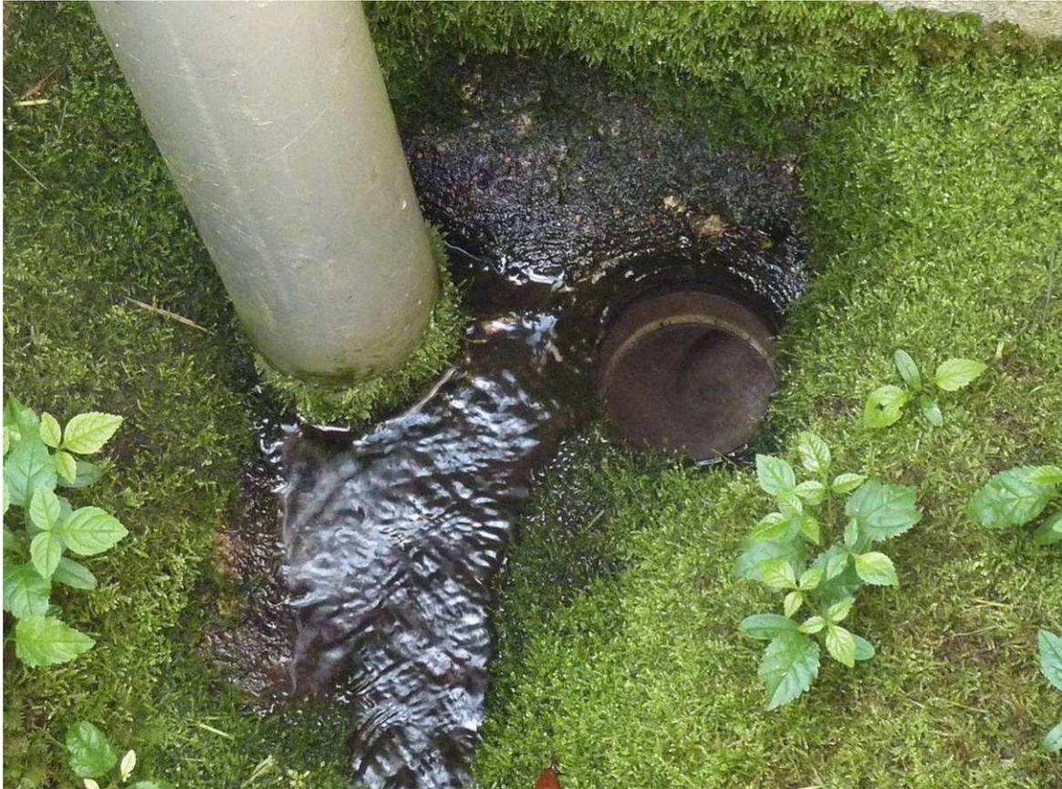
**Développement de mousses et de frênes dans l'ouvrage de répartition (2ème étage), station de Serre sur Arget (09)**
