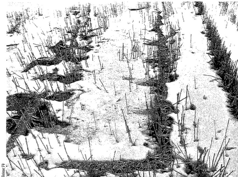
Station d'Allèves. Deuxième étage de filtration sous la neige. Les roseaux sont faucardés à 40 cm. Les eaux usées élèvent la température et fondent la neige autour de la canalisation de distribution.
