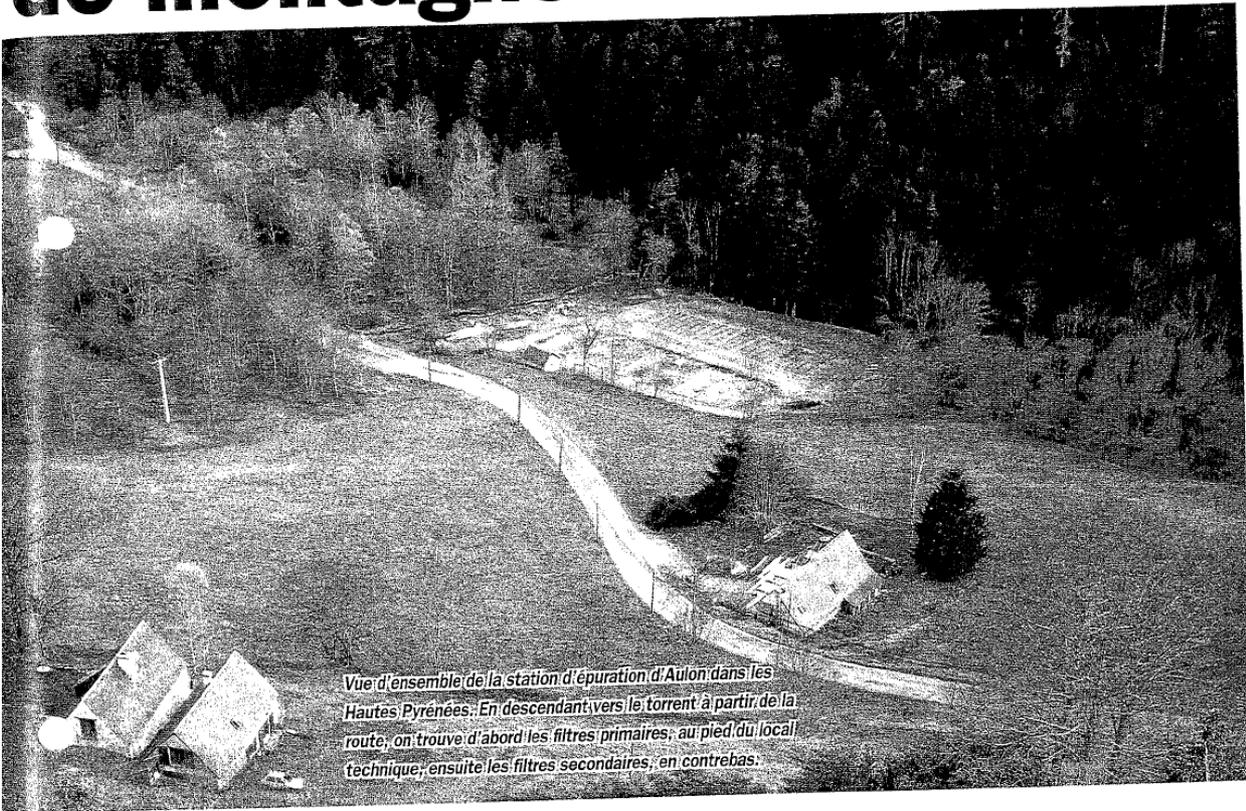
Vue d'ensemble de la station d'épuration d'Aulon dans les Hautes-Pyrénées. En descendant vers le torrent à partir de la route, on trouve d'abord les filtres primaires, au pied du local technique; ensuite les filtres secondaires, en contrebas.
