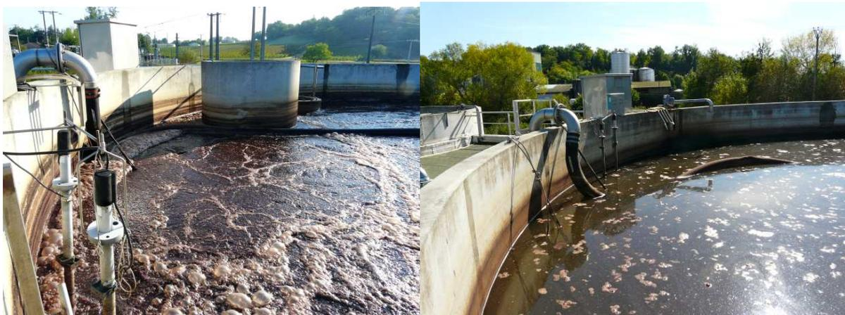
**Photo 14 et Photo 15 : phase d'oxygénation et phase de décantation dans un bioréacteur SBR**
