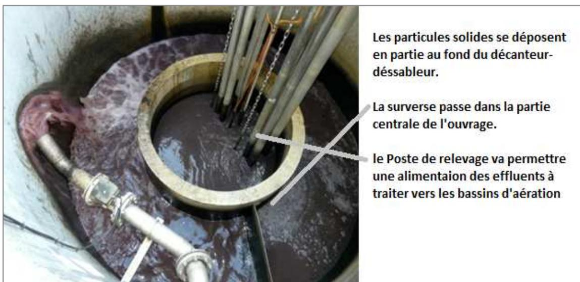
Photo 7 : exemple d'un décanteur-dessableur/ Station de la CUMA des Deux Côtes (Villeneuve de Blaye)
