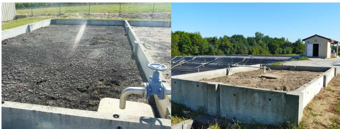
**Photo 9 et Photo 10 : lit de séchage pour les boues décantées et Massif de silice pour le traitement de finition du surnageant- STEP de St Martial (CUMA des Tuileries)**
