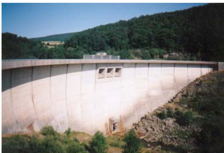
Figure 46 : Barrage de Laouzas (source : Structurae)
