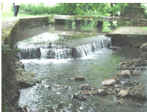
Photo 1 : Seuil en amont de l'étang
