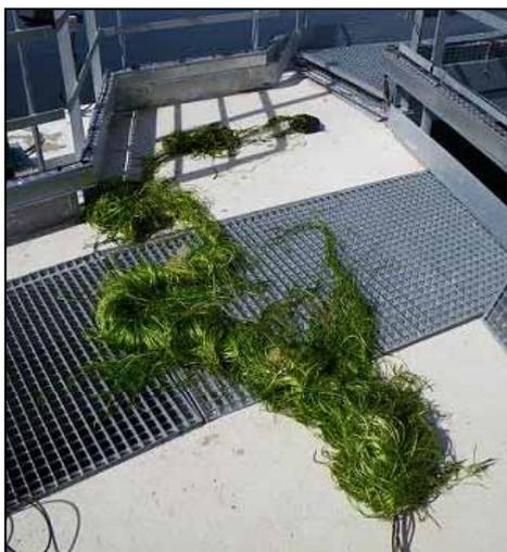
Photo 15 : Antenne brins d'un exutoire secondaire recouverte de renoncules
