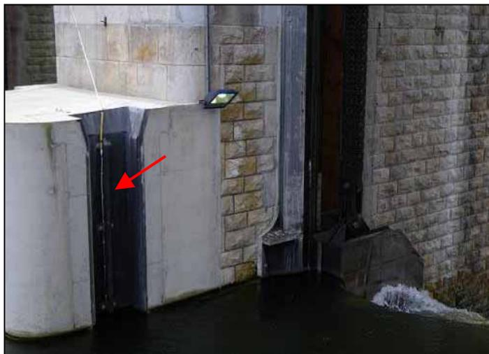
Photo 14 : Antenne brins de l'exutoire principal située dans la rainure du batardeau
