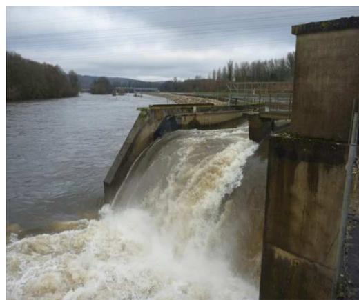
Photo 9 : Clapet de défeuillage de l'usine de Mauzac (position ouvert)
