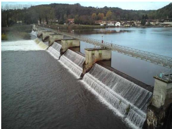
Photo 3 : Barrage de Mauzac et ses vannes-toit
