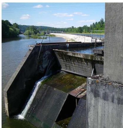
Photo 7 : Clapet de défeuillage de l'usine de Mauzac (position fermée)
