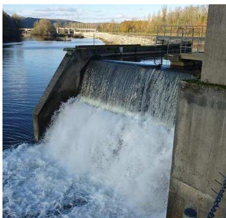
Photo 8 : Clapet de défeuillage de l'usine de Mauzac (position surverse)
