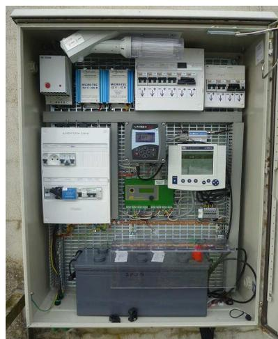
Photo 23 : Coffret d'acquisition de données de la station multi-paramètres DTG installée à Mauzac
