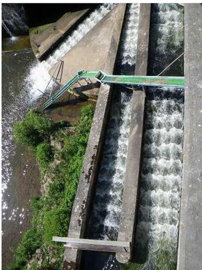
Photo 5 : Passe à ralentisseurs et passe à anguilles du barrage de Mauzac
