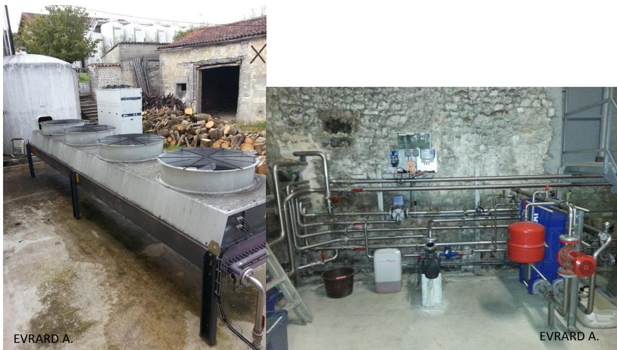
Photo 10 : Refroidissement des eaux chaudes par aéro-réfrigération, Aéro-réfrigérant/poste d'ajout des additifs.
