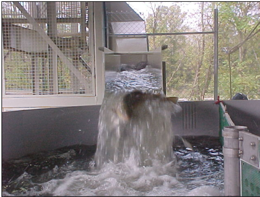
Photo 1 : Déversement d'un salmonidé dans la goulotte de l'ascenseur
