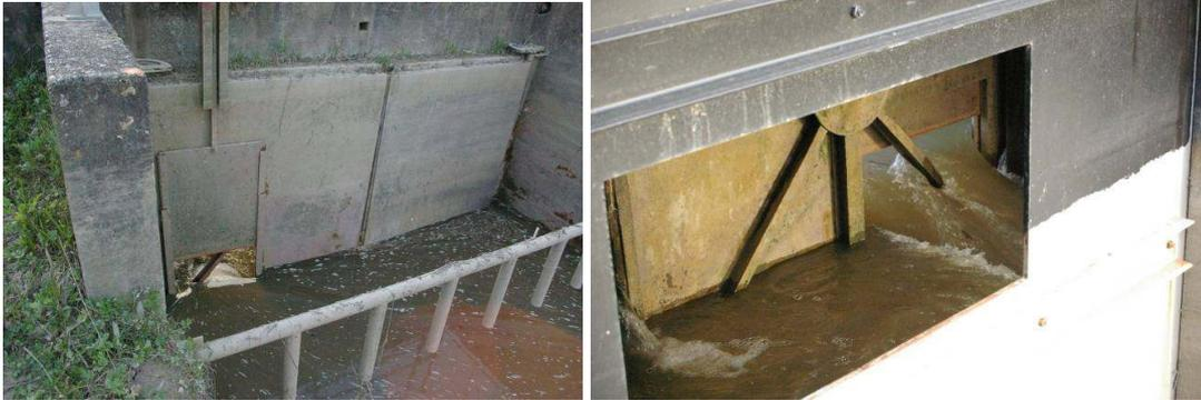
Figure 9 : Vantelle ouverte sur les portes à flot d'Issan, vue de l'aval et de l'amont.
