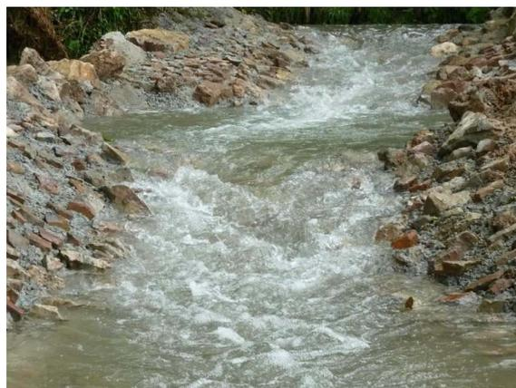
**Figure 53 : Exemple de rampe rustique en enrochements jointifs liaisonnés Moulin Bréval sur la Calonne (27)**
