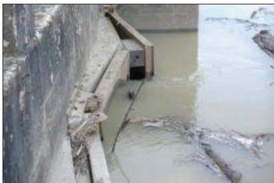
**Figure 15 : Cales installées sur la porte à flot de la Jalle de Castelnau à marée montante.**
