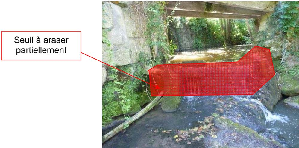
**Figure 52 : Schéma de l'arasement partiel du seuil du moulin du Limousin – source ECOGEA, 2012**
