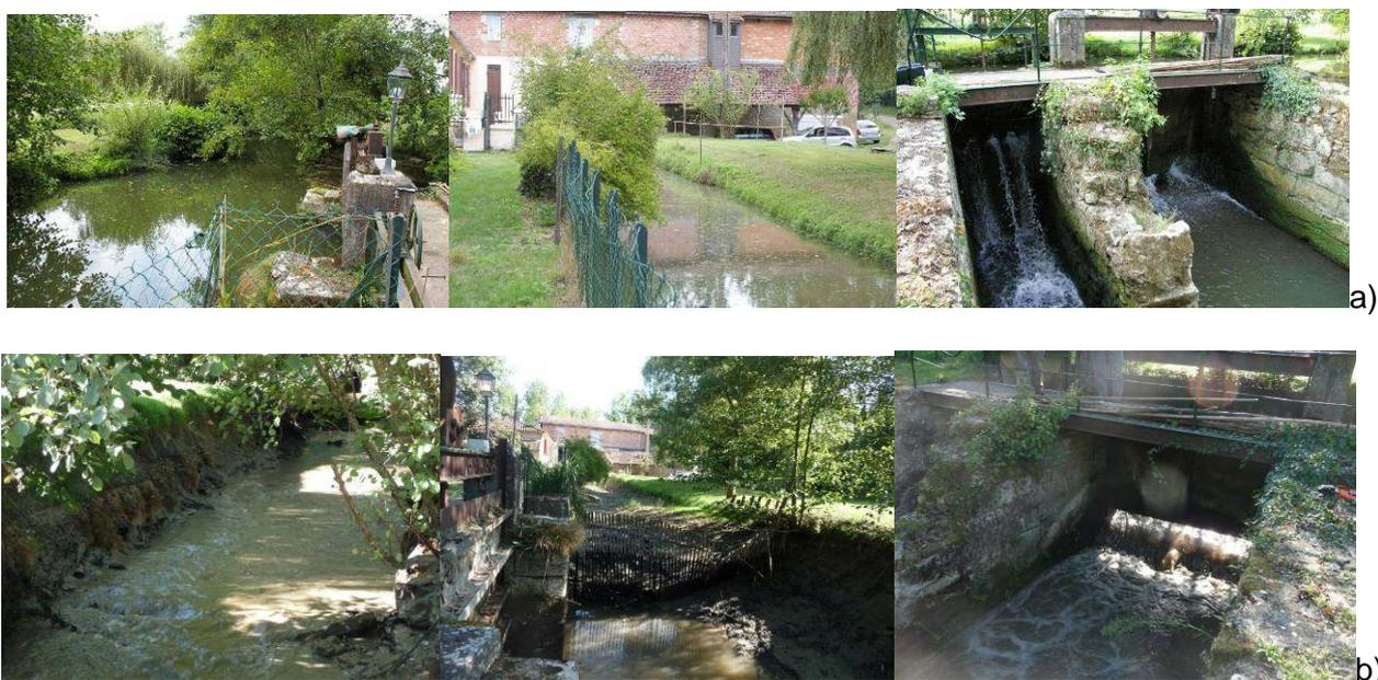
**Figure 47 : Moulin Rabèze avant ouverture des vannes (a) et après ouverture des vannes (b).**
