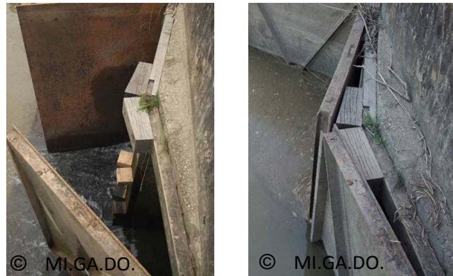
**Figure 5 : Des cales en chêne au niveau des portes à flot d'Arcins, à marée basse (portes à flot ouvertes) et à marée montante (portes à flot fermées laissant une ouverture de 10 cm sur toute la hauteur).**
