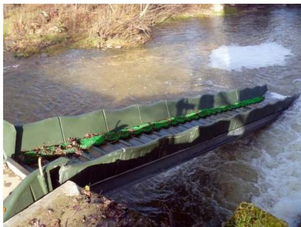
**Figure 11 : Passe à canoës associée à une passe à anguilles sur la Gélise. En cours de test. Source : Yanick Birkly, 2012**
