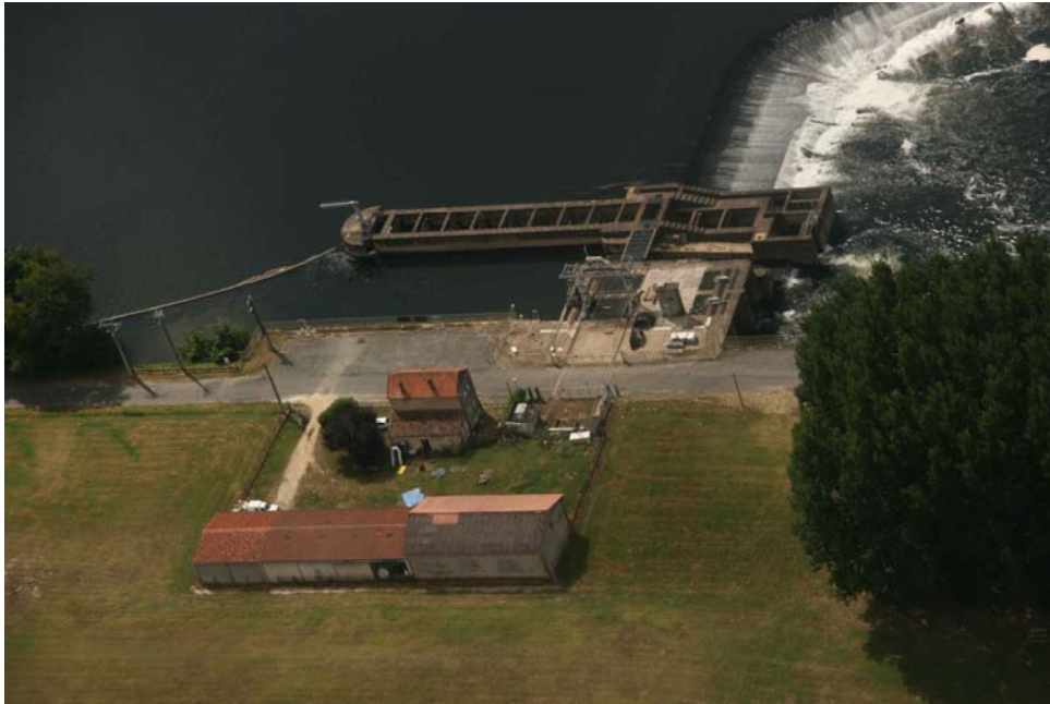
Photo 1: Vue aérienne du Centre de reconditionnement de Bergerac
