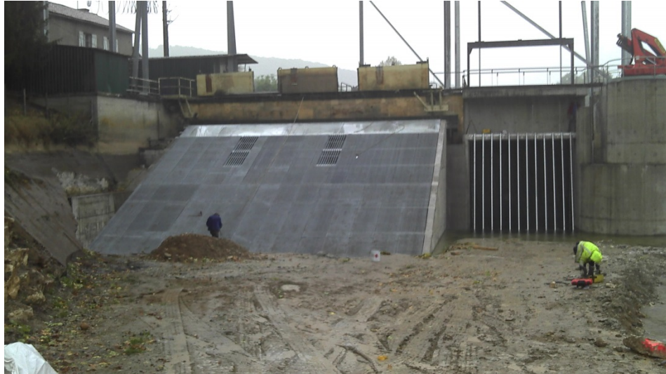
Figure 6 : Photographie de l'installation du plan de grilles fines sur la prise d'eau des turbines (groupe bulbe) à Aubas.
