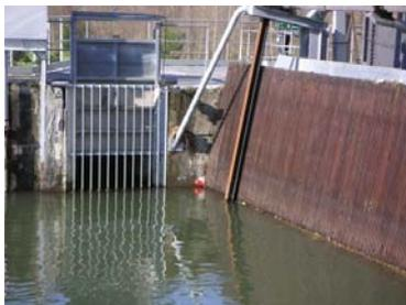
Les dispositifs de piégeage sont intégrés aux exutoires, ils sont chacun constitués d'une grille filtrant le débit. Les poissons glissant sur la grille tombent dans une goulotte qui les entraîne dans un bassin de stabulation. Pendant le transit, les poissons sont filmés pour être comptabilisés.
