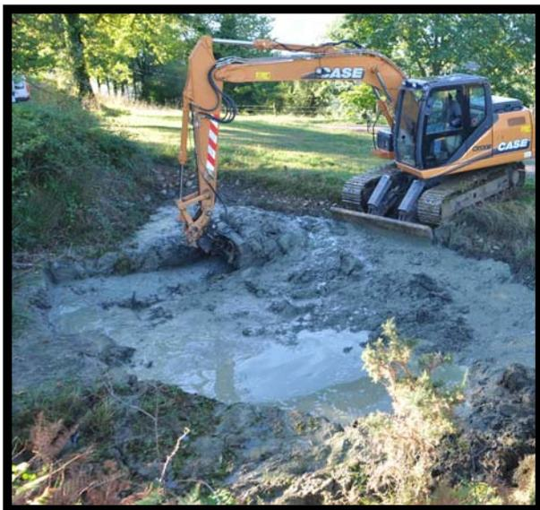
✂ **21 curages mécaniques.** Une pelle mécanique a procédé au curage de la vase et au reprofilage des berges en pente douce, tout en lissant le fond de la mare avec un godet simple et lisse.
