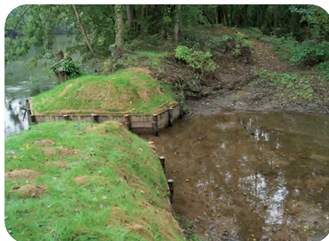
Ensemencement sur fibre coco sur le bras mort des Bouysses dans le Lot (46).
