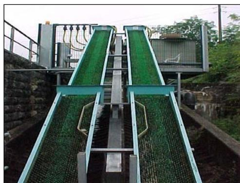
**Figures 11 et Figure 12 : Partie aval et amont de la passe à anguilles**
