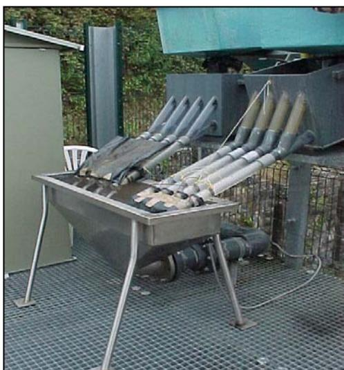
**Figure 14 : Tubes du compteur à anguilles**
