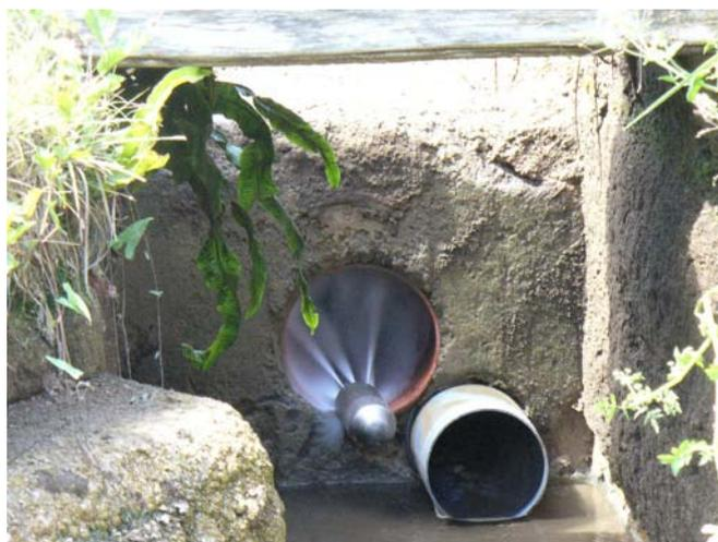
**Figure 6 : Nettoyage des canalisations par jet d'eau à haute pression.**
