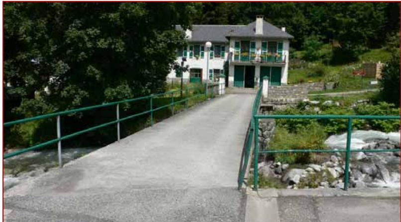
*Pendant la crue, l'eau débordée en amont (effet tremplin + effet défecteur) érode le pied de versant en amont du bâtiment – la passerelle d'accès ne semble pas en charge – source D.Platon, CNRS/Géode*
