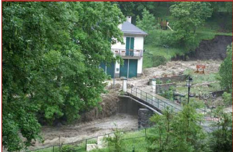
*Pendant la crue, le bâtiment constitue un point dur/saillant, qui fait défecteur et accentue l'érosion du pied de versant – la passerelle d'accès ne semble pas en charge – source D.Platon, CNRS/Géode*
