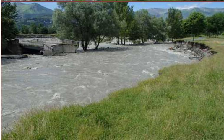
*La Garonne à Fos (31) – le pont de la 2x2 voies renforce un verrou géologique – son orientation et le fait que son arche rive droite tende à se fermer (alluvionnement progressif) concentrent les écoulements et les dirigent vers la partie basse du bourg de Fos*
