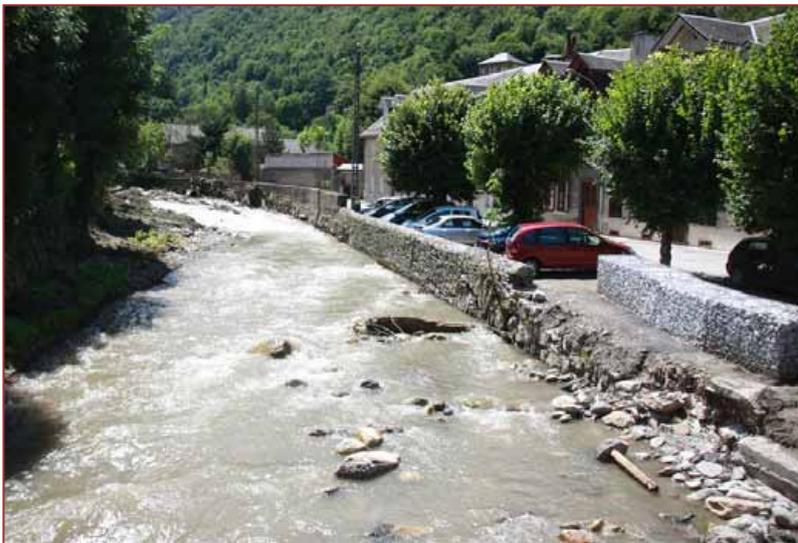
*Le Bastan à Barèges (65) – rupture d'une protection de berge par affouillement – source D.Platon, CNRS/Géode*
