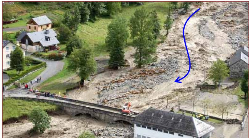
*Cône de la Mousquère à Bourisp (65) – Dépôt d'alluvions curées, en amont d'un franchissement sous-capacitaire (GéoDiag)*
