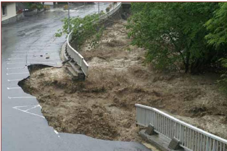
*L'Yse à Luz-St-Sauveur (65) – Protection de berge détruite – source A. Burens, CNRS/Géode*
