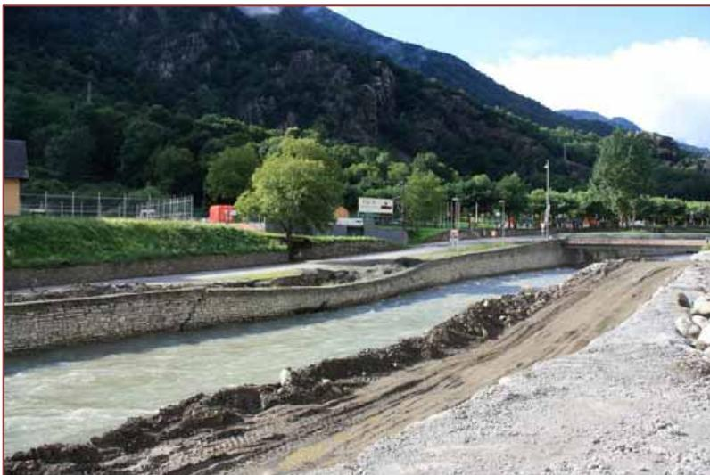
*La Pique à Bagnères de Luchon (31) – rupture d'un mur/digue – source CNRS/Géode*
