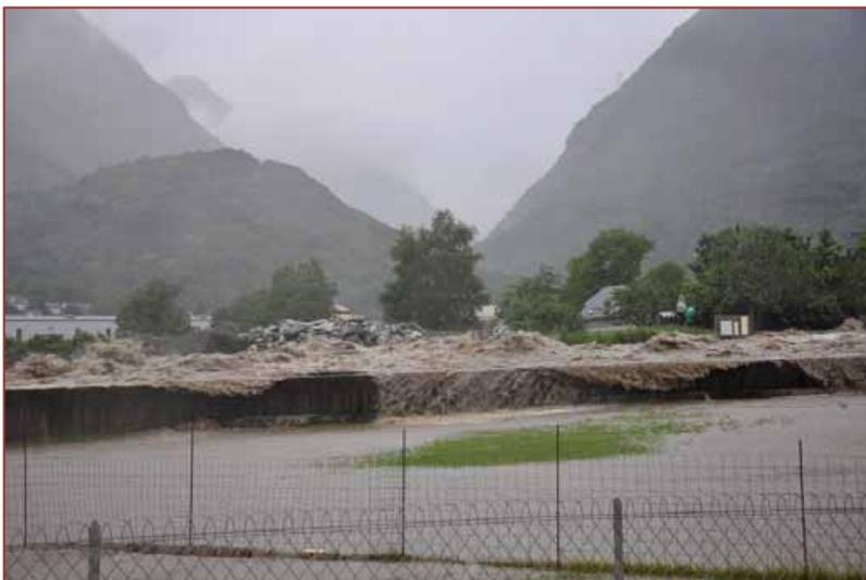
*La Garonne dans le val d'Aran – Affaissement d'une protection de berge dans le lit mineur suite à l'érosion derrière le mur et/ou à l'affouillement en pied de berge – source CNRS – Géode*
