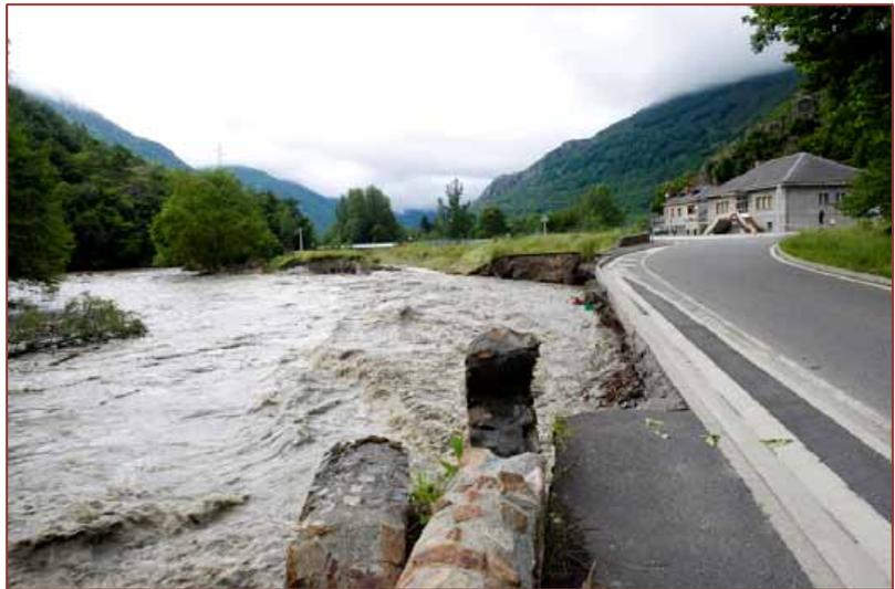
*Le gave de Gavarnie à Saligos (65) – Erosion latérale, à l'aval immédiat d'une protection de berge en enrochement*
