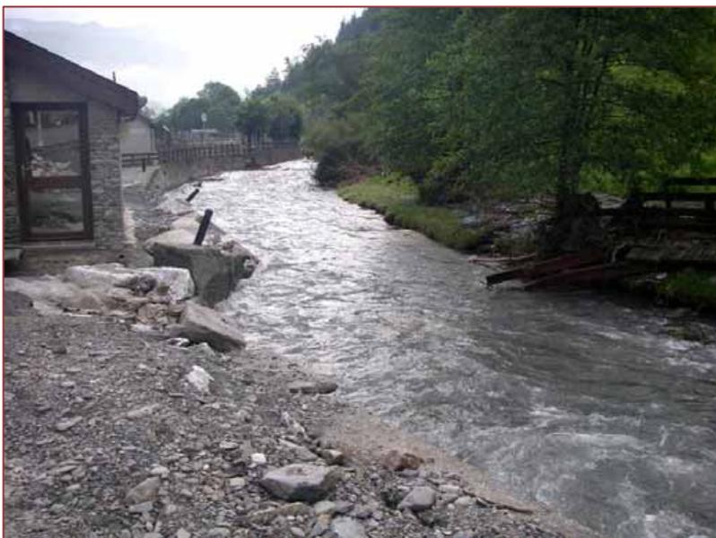
*La Neste du Louron à Arreau (65) – En basculant dans le lit, la passerelle s'est transformée en épis déflecteur – source DDT65*
