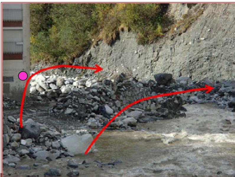
*Le Bastan à Barèges (65) – le torrent en crue a contourné les bâtiments saillants et érodé le versant en rive opposée (source DDT65)*
