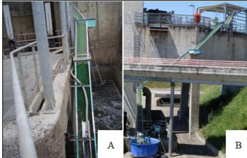
**Figure 21 : La passe à anguilles actuelle de Golfech. En A, la passe partie inférieure, en B, la passe partie supérieure.**
