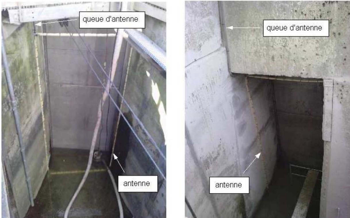
Figure 10 : Vue des antennes 1 (à gauche) et 2 (à droite) installées à Golfech en 2012.
