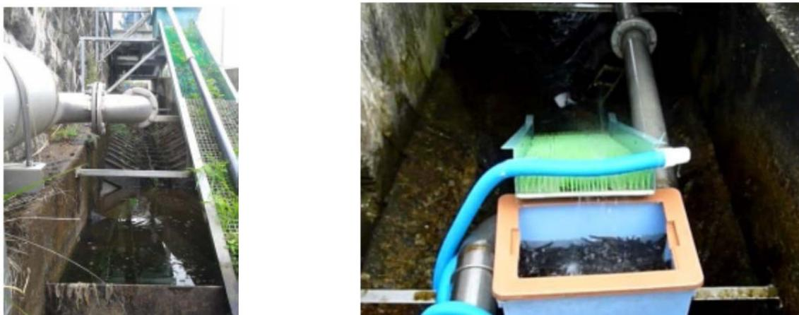
**Figure 19 : Vue de la partie amont de la passe à ralentisseurs (sous la rampe brosse) et de la passe provisoire installée en 2013 à Tuilières**
