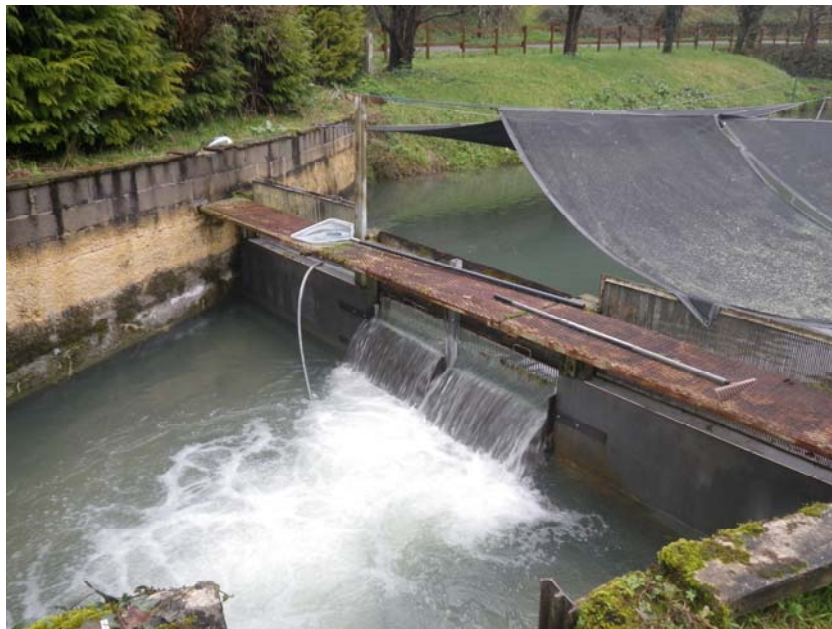
Photographie 2 : Déversoir aval de l'étang après sécurisation du bâti pour contrôler le niveau amont.
