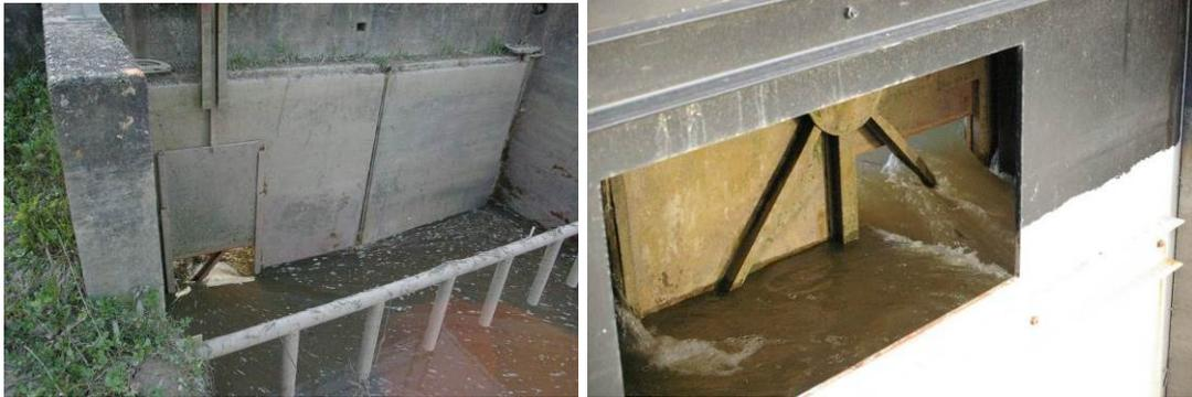
Figure 33 : Vantelle ouverte sur les portes à flot d’Issan, vue de l’aval et de l’amont.
