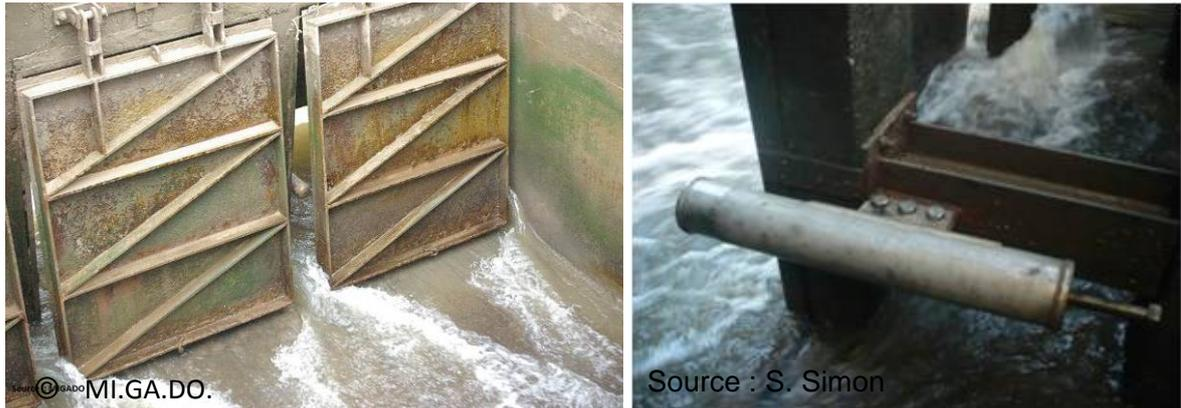
**Figure 31 : Raidisseurs installés sur les clapets de la jalle du Breuil. Source : MIGADO et S. Simon, 2010**
