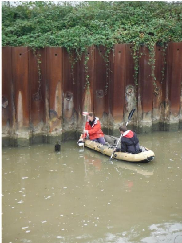
**Figure 41 : Réalisation de profils en travers et en long des jalles en amont des ouvrages.**
