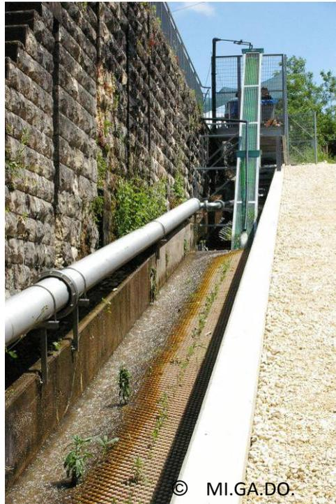
**Figure 14 : Nouvelle passe à anguilles installée sur le site de Tuilières en 2010.**
