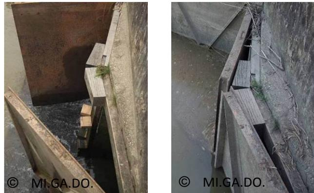
**Figure 29 : Des cales en chêne au niveau des portes à flot d'Arcins, à marée basse (portes à flot ouvertes) et à marée montante (portes à flot fermées laissant une ouverture de 10 cm sur toute la hauteur).**
