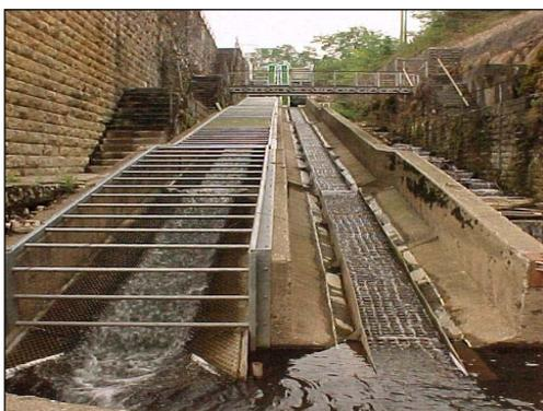
Figure 11: Partie aval de la passe à anguilles
