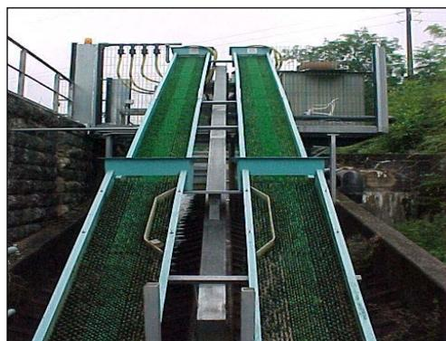
Figure 12 : Partie amont de la passe à anguilles
