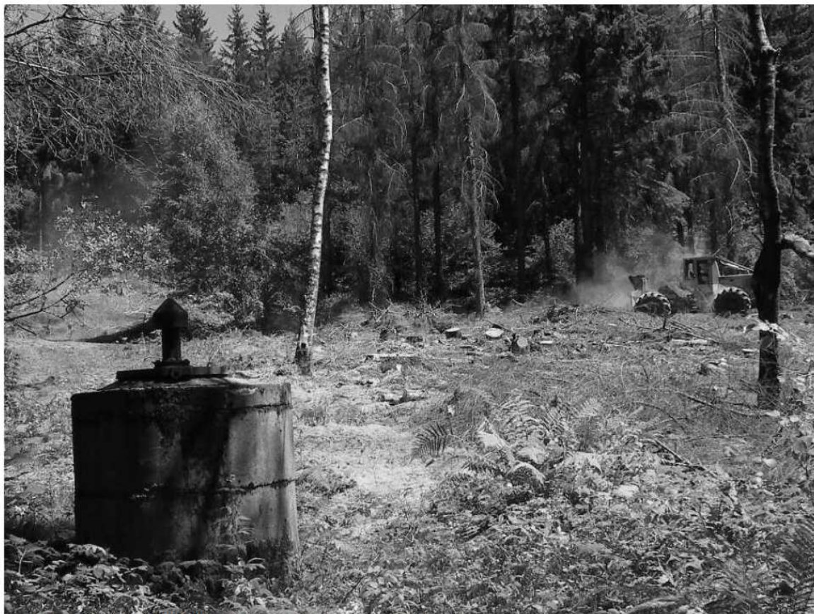
Figure 5 : Chantier d'exploitation en périmètre rapproché de captage.
