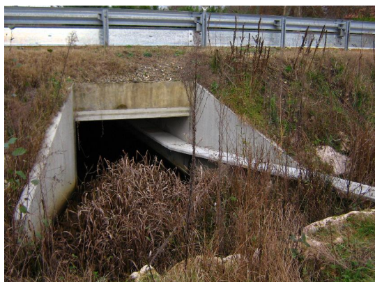
Banquette dans un ouvrage, protection sous glissière
