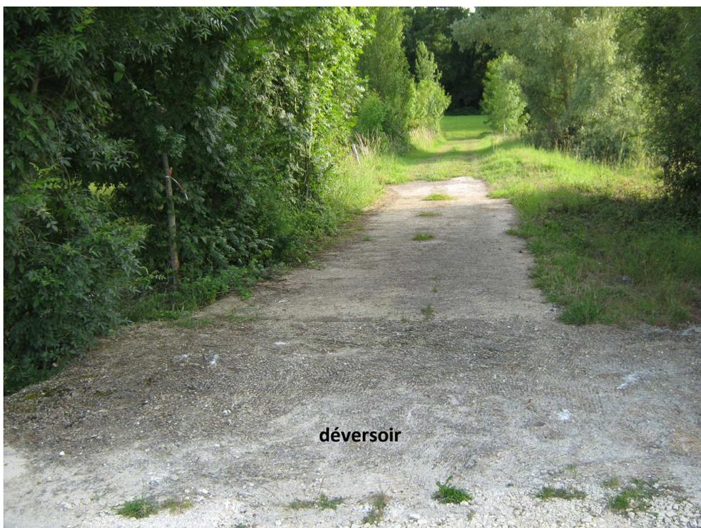
La rehausse du plan d'eau implique la rehausse de la digue amont. Sa cote actuelle à 86,6 m NGF environ sera relevée de 50 cm. Le déversoir en béton sera ragréé par-dessus l'existant à l'aide d'un béton cyclopéen. Il sera calé à la cote 86,65 m NGF.
