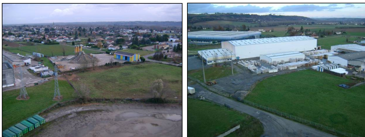
Illustration n°10 : Bâti en zone inondable sur Valence
