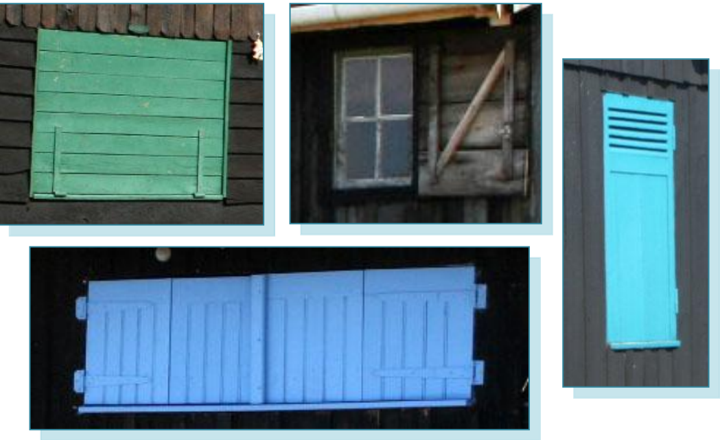
Figure 41 : La diversité des formes De gauche à droite : volet basculant, fenêtre petit format traditionnelle à petit bois, ouverture "meurtrière" avec persiennes et ouverture "bandeau"
