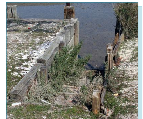
Figure 65 : Emmarchement intégré au quai
