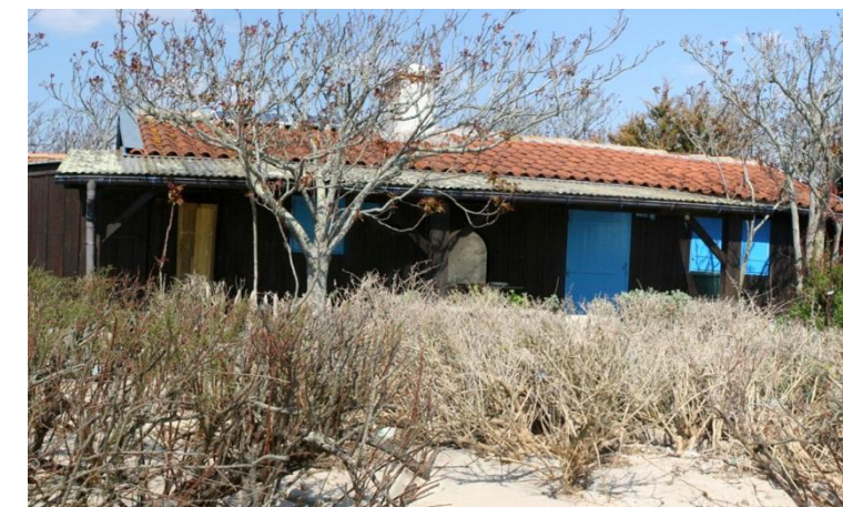
Figure 10 : Auvent partiel et décalé, en façade, couverture fibrociment (Cabane n°48)
