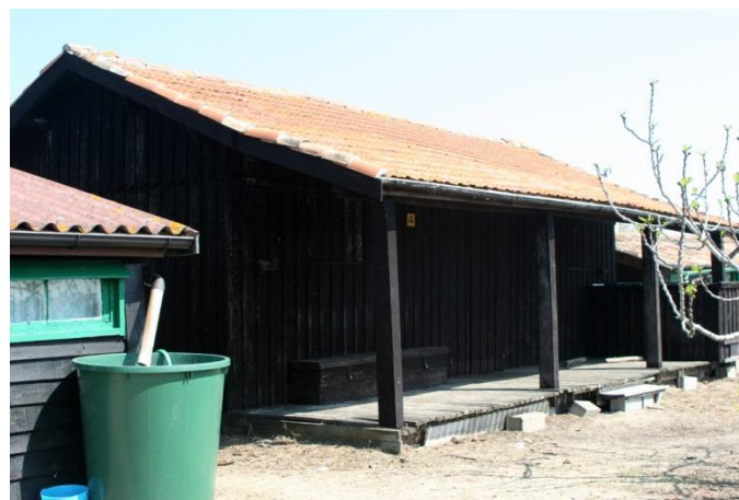
Figure 9 : Auvent en façade (Cabane n°4)
