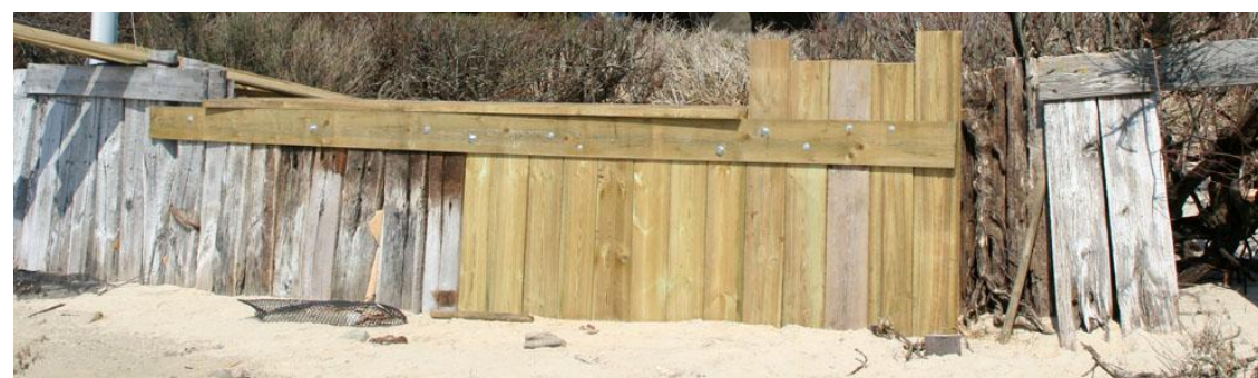
Figure 67 : Rénovation d'une portion de quai à l'Îlot
