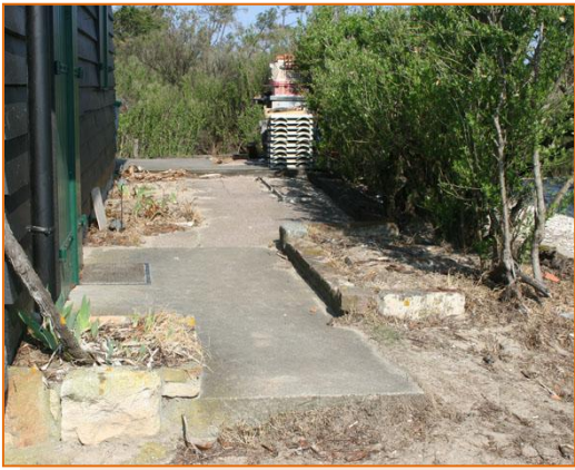
Figure 50 : Terrasse et bordures en béton, dalles de béton désactivé et bois, plantations et stockage de matériaux
