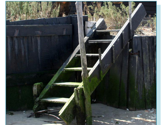
Figure 64 : Escalier en bois
