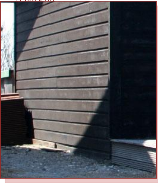
Figure 16 : Bardage de bois à lames horizontales sans recouvrement (bouvetées)
