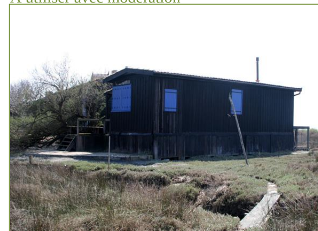
Figure 21 : Habillage du soubassement en bardage bois (Cabane n°55)
