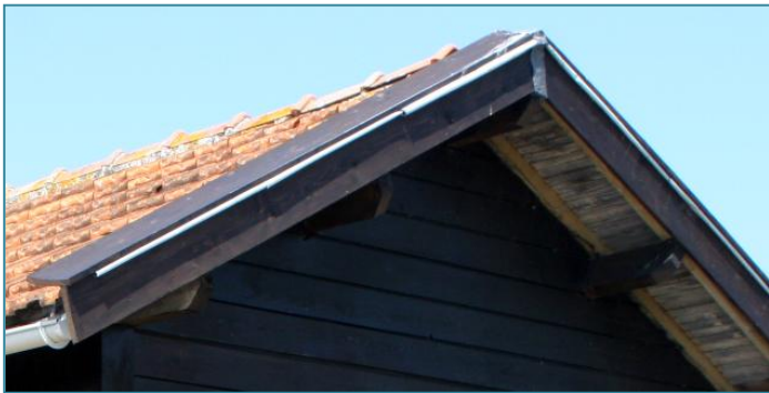
Figure 36 : Recouvrement horizontal des rives par le bandeau en bois et zinc
