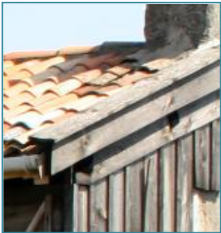
Figure 36 : Recouvrement horizontal des rives par le bandeau en bois et zinc
