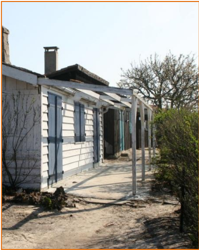
Figure 54 : Pergola et terrasse en béton
