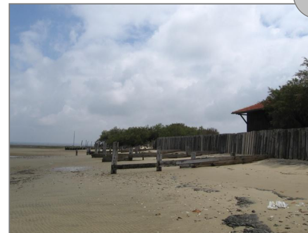
17.05.2010 – Nuageux -1,177555° ; 44,704523° - Est Estran sableux et ouvrages de protection des cabanes
