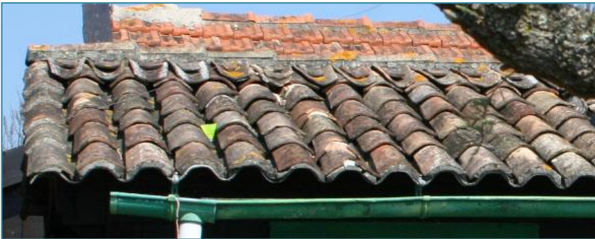
Figure 32 : Tuiles canal sur support fibrociment
