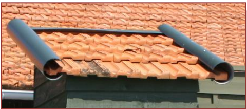
Figure 40 : Rives en tube PVC pour une annexe (WC)
