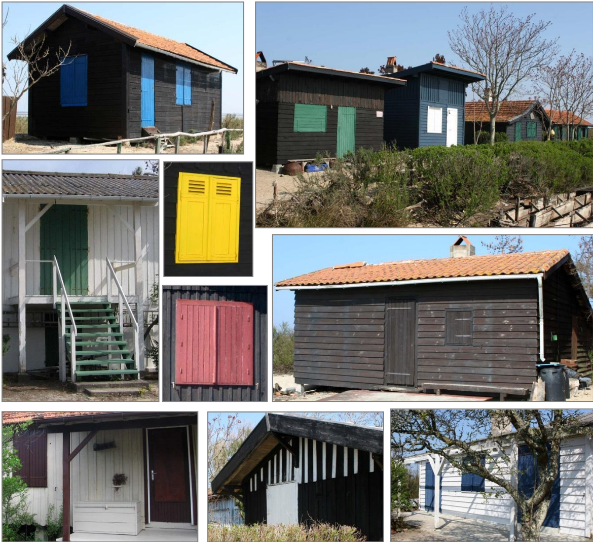
Figure 47 : Aperçu de la diversité des colorations des menuiseries
