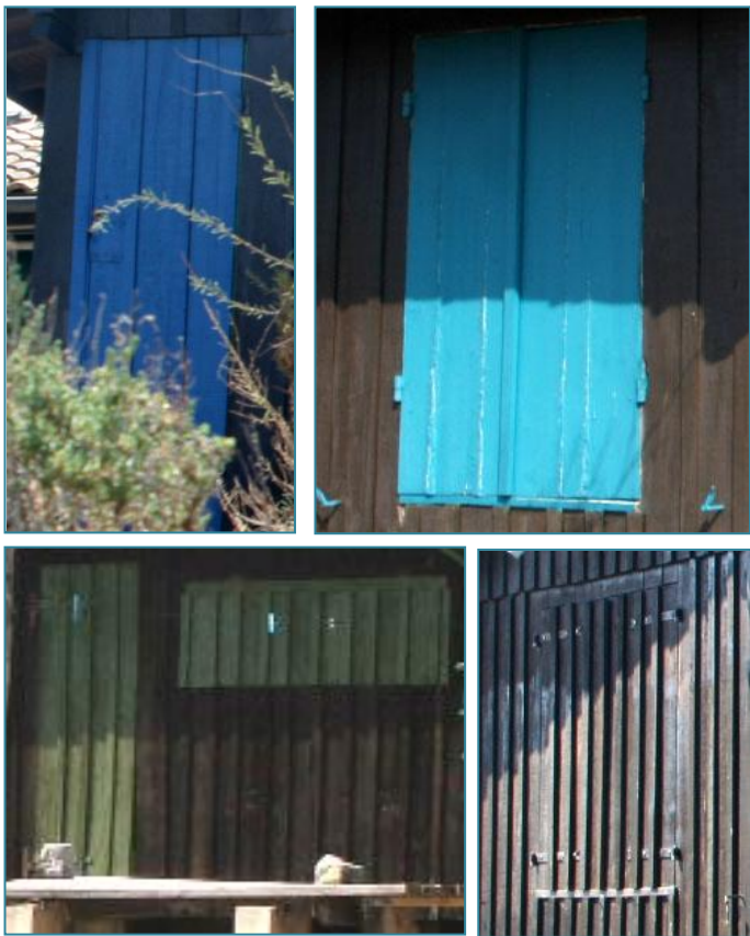
Figure 42 : Portes et volets en bois dans la continuité du bardage
