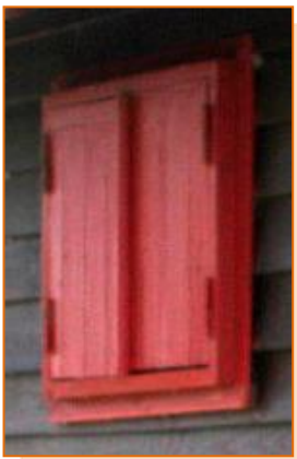
Figure 44 : Fenêtre en saillie sur la façade
