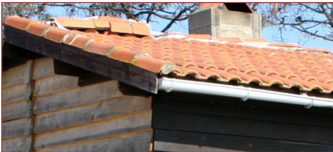
Figure 28 : Couverture en tuiles romanes canal et bandeau bois
