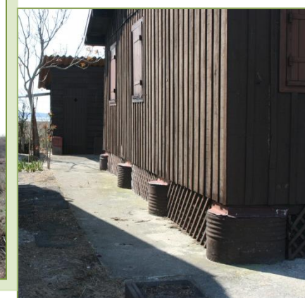
Figure 22 : Habillage de la surélévation en bidons métalliques et claustra
