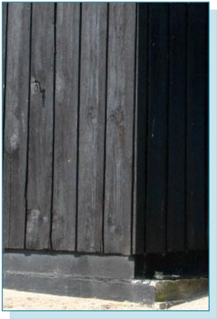
Figure 14 : Bardage de bois vertical avec couvre joint
