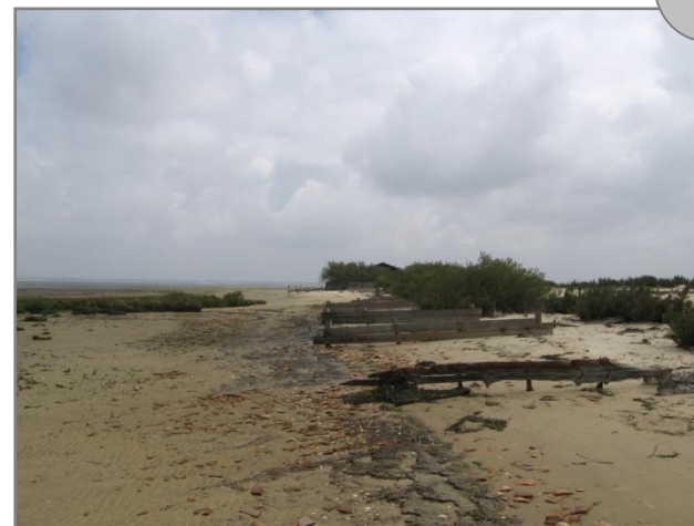
17.05.2010 – Nuageux -1,179025° ; 44,704128° - Est Estran sableux et ouvrages de protection
