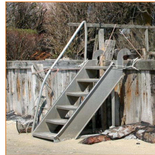
Figure 62 : Escalier en métal avec garde-corps
