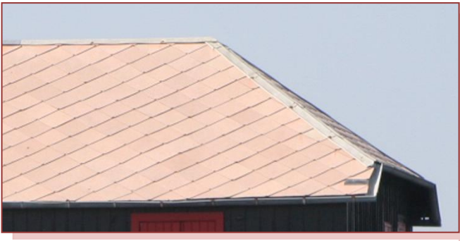
Figure 29 : Couverture en tuiles plates
