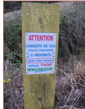
Concernant les conduites souterraines de transport, elles traversent le réseau hydrographique du Midou en de nombreux points et sont signalées visuellement par un système de bornes.
