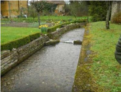
Dans sa partie aval, le Cornac traverse le bourg de Lizant. Le cours d'eau est rectifié et déplacé. Plusieurs petits seuils fixes y sont édifiés. Les berges sont matérialisées par des murs de rive. On note l'absence de colmatage.
