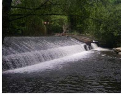
L'aval du segment est influencé par la chaussée (présence d'une passe à poissons non fonctionnelle) du moulin de Tézier. La lame d'eau est homogène et les écoulements lenticques.
