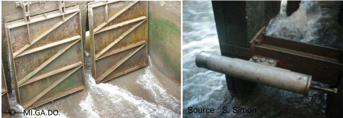
**Figure 57 : Raidisseurs installés sur les clapets de la jalle du Breuil. Source : MIGADO et S. Simon, 2010**
