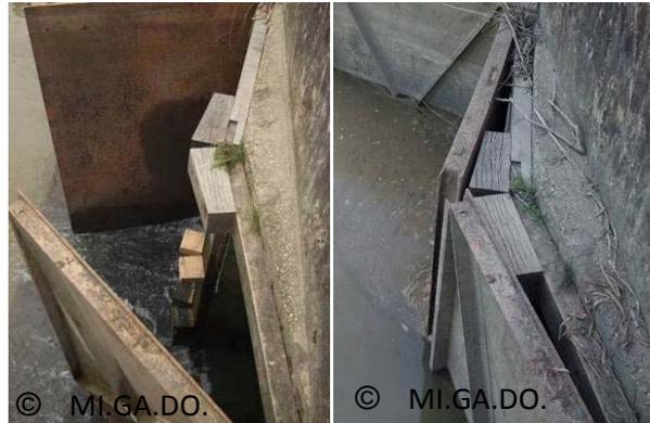
**Figure 55 : Des cales en chêne au niveau des portes à flot d’Arcins, à marée basse (portes à flot ouvertes) et à marée montante (portes à flot fermées laissant une ouverture de 10 cm sur toute la hauteur).**
