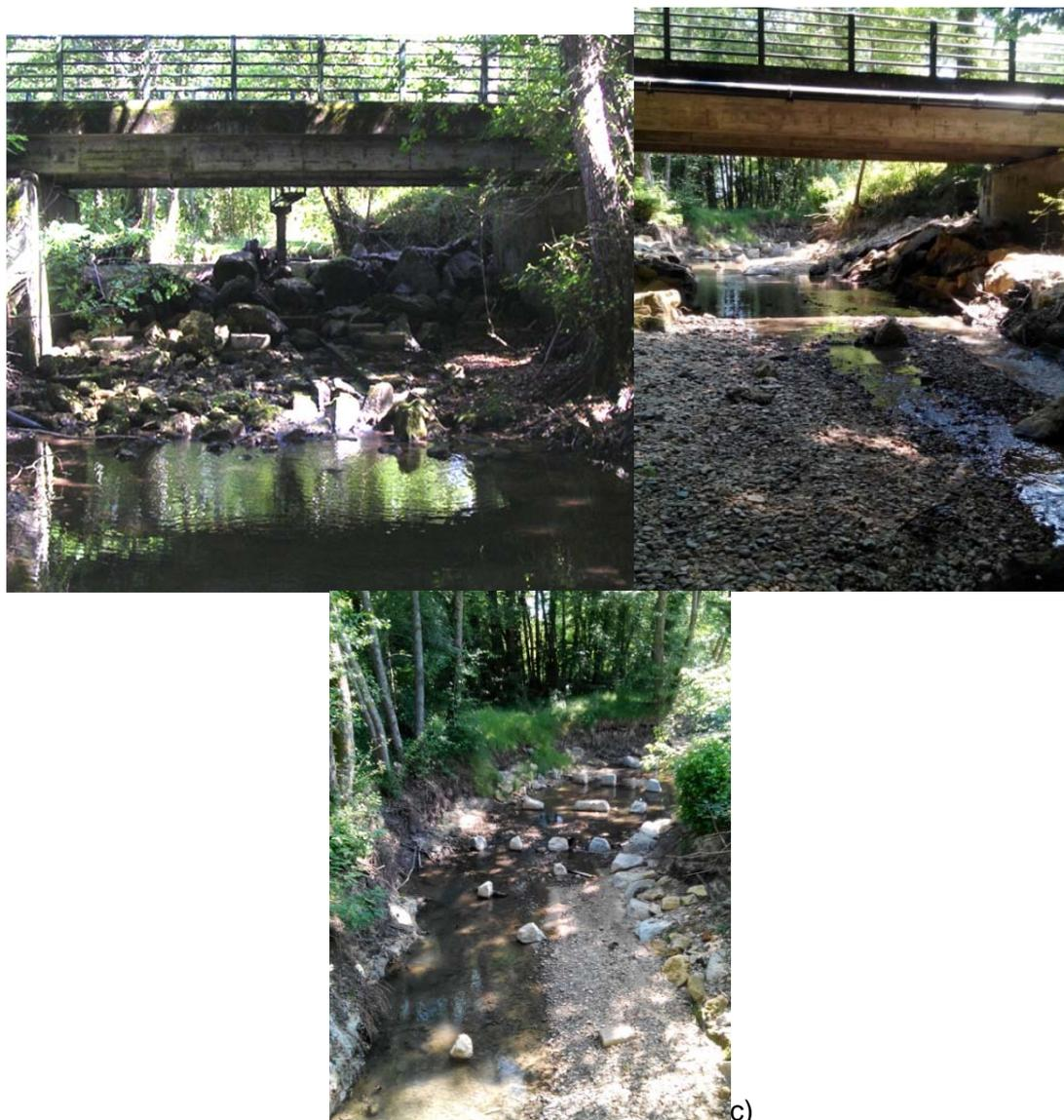
**Figure 18 : Impact des ouvrages à la migration de montaison sur Barailler/Eyraud (a), arasement de l'ouvrage aval, Moulin du Coutou b), démantèlement et réaménagement du seuil de répartition du Pont de Chateau c)**
