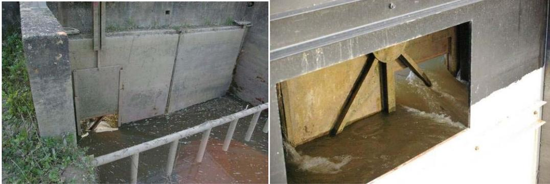
**Figure 59 : Vantelle ouverte sur les portes à flot d'Issan, vue de l'aval et de l'amont.**
