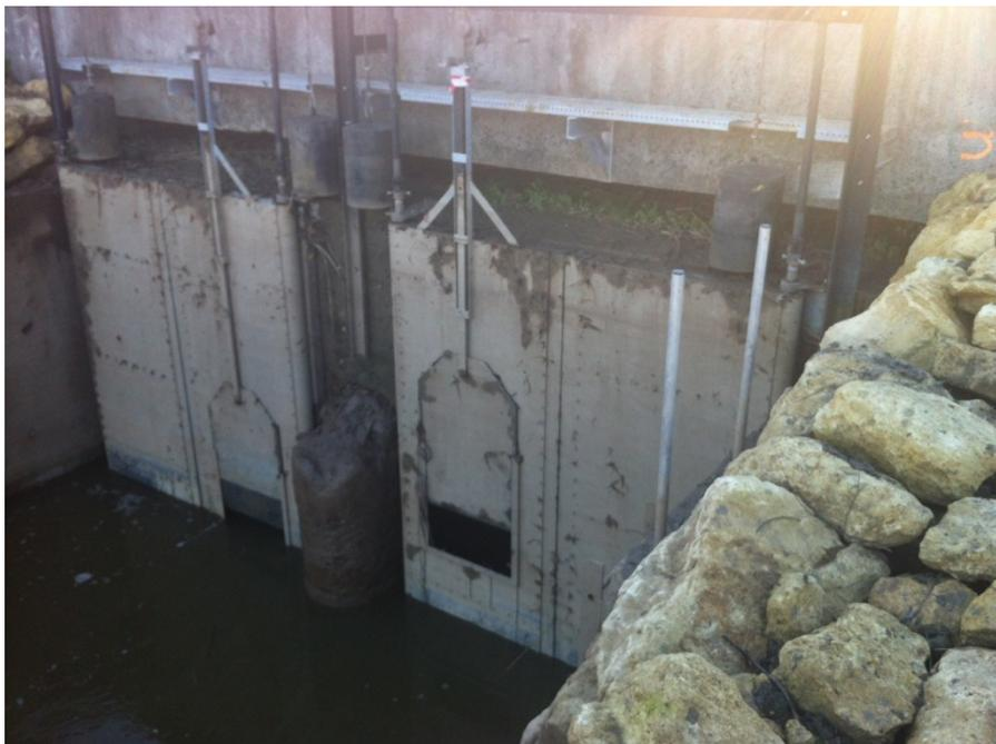
**Figure 63 : Porte à flot de Despartins aménagée avec une vanelle haute et une vanelle basse.**
